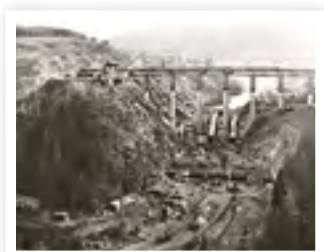
Der Bau der Bleilochtalsperre begann 1926.
