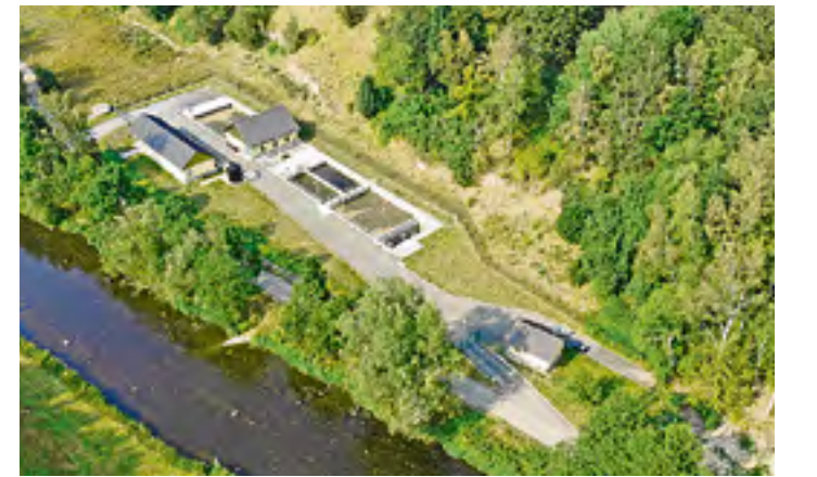
Die Pumpen der Kläranlage in Hirschberg arbeiten seit 2017 einwandfrei. Foto: ZWOS/Hübner
