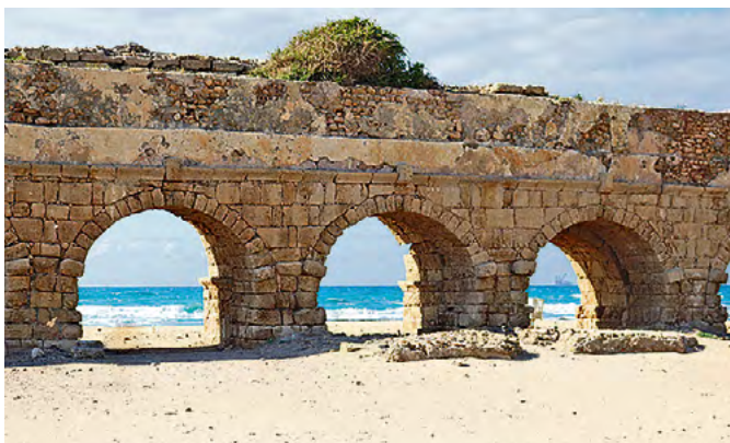
Römisches Aquädukt bei Caesarea in Palästina (ca. 1. Jh. n. Chr.). Die Leitungen bestanden meist aus Stein, wobei auch Holz, Leder und Blei zum Einsatz kamen.
