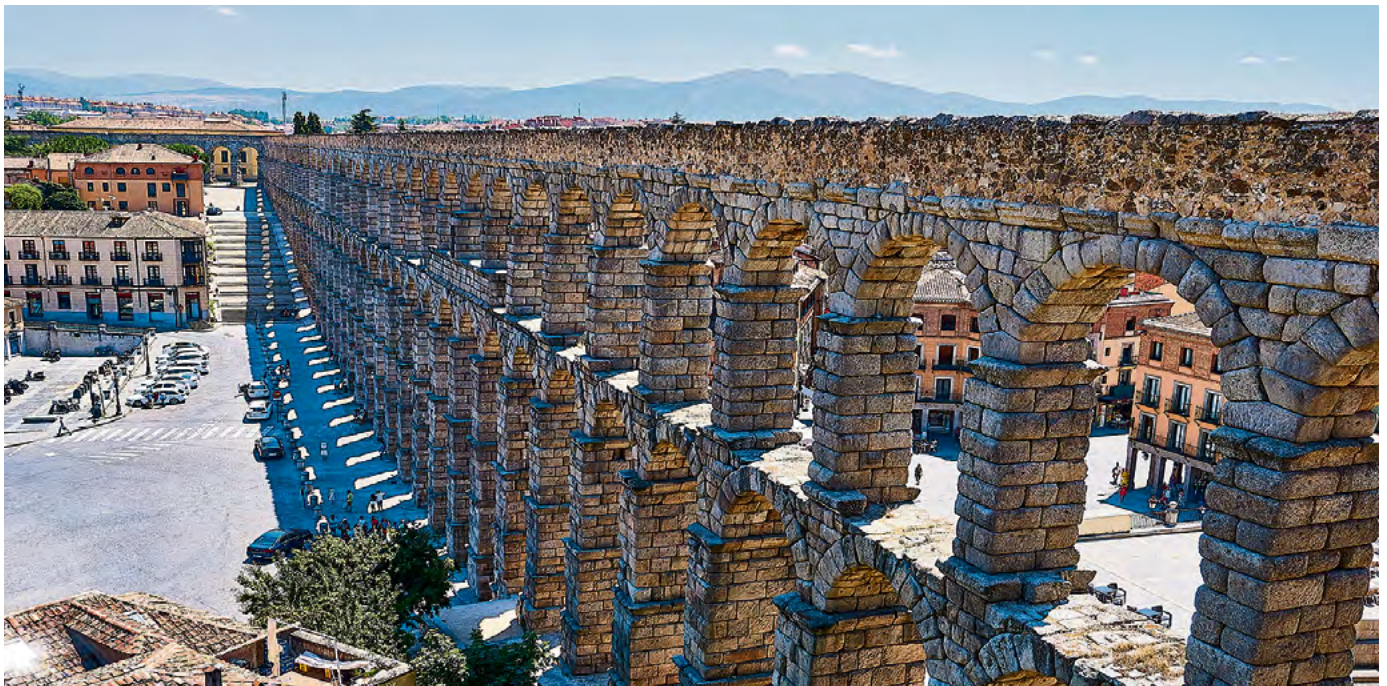
Die 730 m lange Brücke im spanischen Segovia gehörte zu einem 18 km langen Aquädukt, das Wasser in die Stadt brachte. Dieses Meisterwerk römischer Baukunst aus dem 2. Jahrhundert n. Chr. ruht auf 118 Bögen aus Granitsteinen, die ohne Mörtel zusammengefügt wurden.
