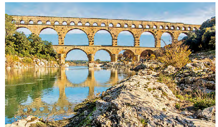
Der zwischen 40 und 60 n. Chr. errichtete 50 m hohe Pont du Gard bei Nîmes ist wohl das bekannteste Brückenaquädukt der Römer. 40.000 m 3 Wasser wurden hier täglich nach Nîmes transportiert.
