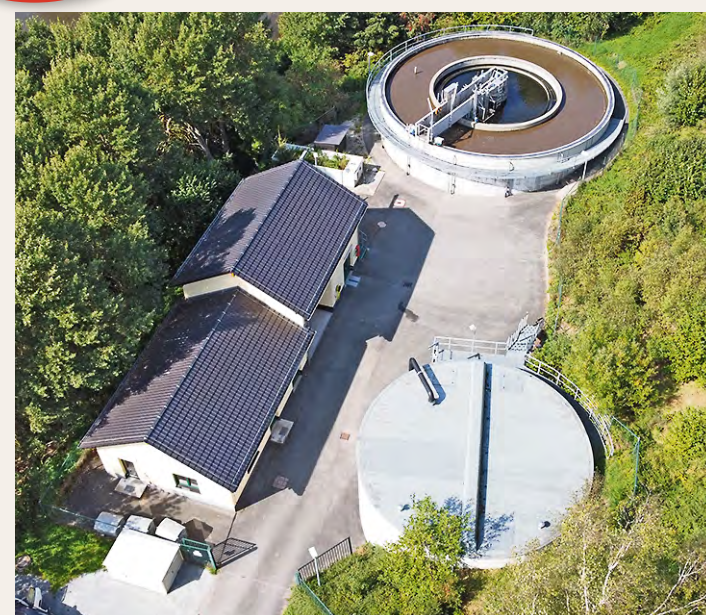
Die Kläranlage Tanna wurde nach 16 Jahren teilweise saniert.
