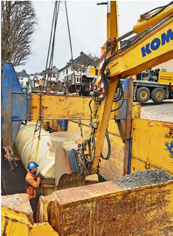
Die Mitarbeiter der Firma UTR aus Schönbrunn bei der Verlegung des Stauraumkanals.
