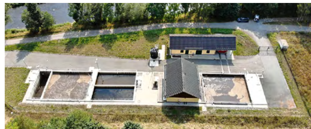
2022 wurden weitere Ortschaften an die Kläranlage Hirschberg angeschlossen.
