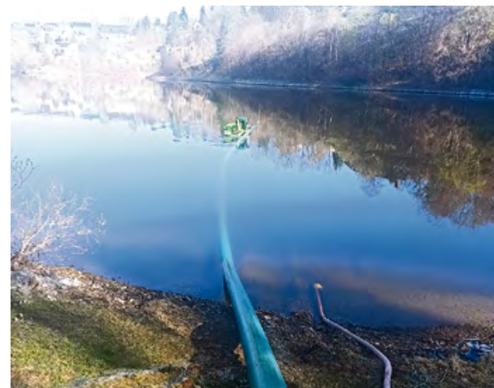
Hier wird das Rohr aus der Richtung der Bleilochtalesperre eingezo-gen.
