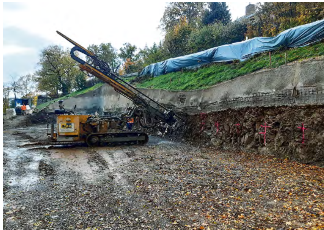
Zur Hangsicherung der Landesstraße werden Bohrlöcher für die Verankerung der Bodennägel eingebracht.
