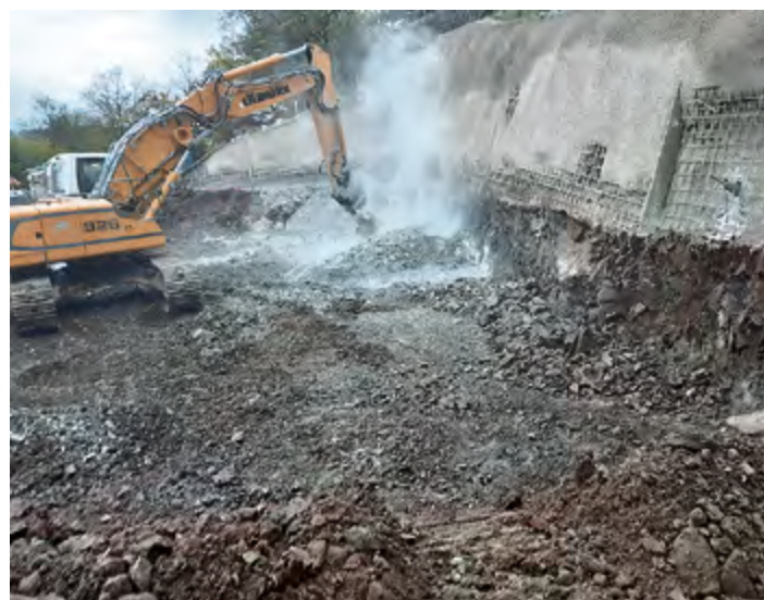
Der schwer lösliche Fels stellt die Arbeiten vor große Herausforderungen.
