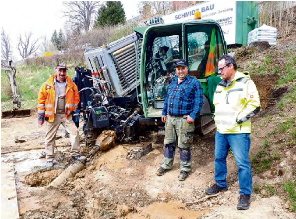
Artur Kurz (UTR GmbH Schönbrunn), Kevin Schmidt (Schmidt Bau GmbH Plauen) und Jörg Brunzel (ZWOS) nach dem erfolgreichen Einzug des Rohres in den Schacht zur Kläranlage Saalburg (v.l.). Foto: ZWOS/Brunzel
