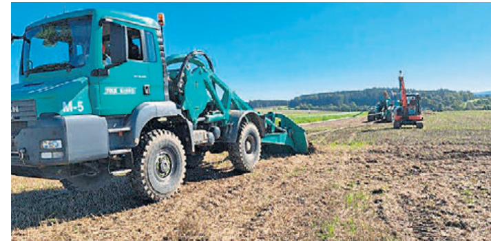
Einsatz des Rohrflugkomplexes zwischen Erkmannsdorf und Eßbach. Der vordere LKW dient als Widerlager, der Pflug zieht sich mittels eines Stahlseils in Richtung Widerlager.
