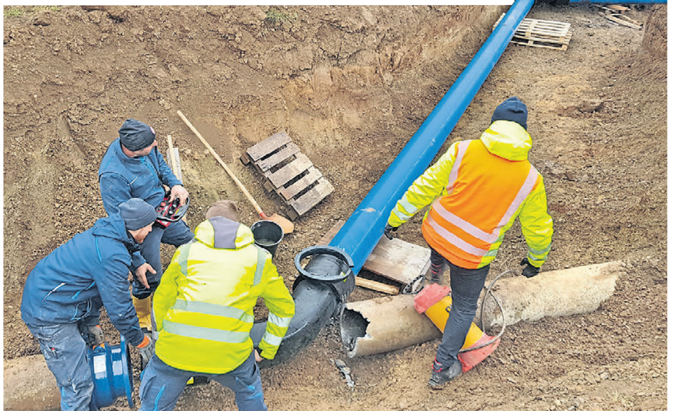
Die Mitarbeiter des ZWOS bei der Umverlegung der Trinkwasser-Versorgungsleitung DN 300 auf einer Länge von zirka 50 Metern im Gewerbegebiet Oettersdorf.
