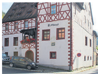
Die Außenfassade des Rathauses ist nur aufgemalt und imitiert das Fachwerk im oberen Teil des Hauses.
