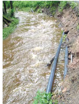
Kostenintensiv: Viele Versorgungsleitungen wurden freigespült.
