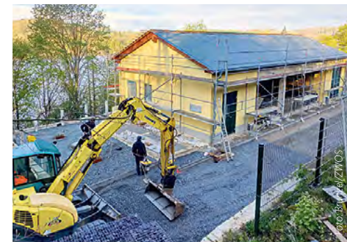
Die Arbeiten an der Kläranlage Saalburg gehen voran. Der Testbetrieb soll im Juni 2024 beginnen.
