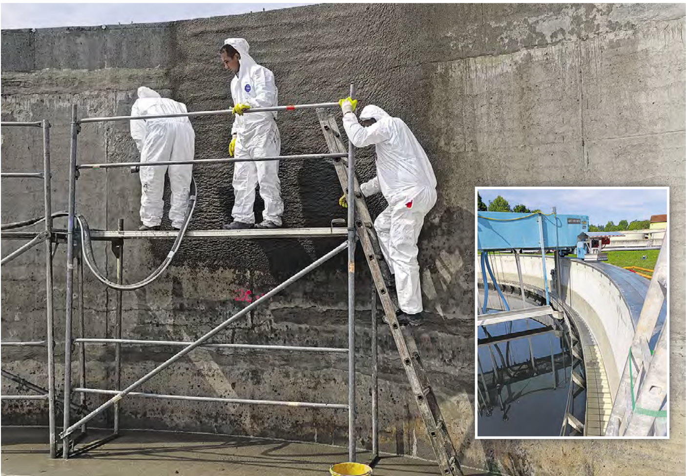
Damit die Bauwerke auch in Zukunft sicher und funktionsfähig bleiben, fallen immer wieder im Verbandsgebiet etwa Betonsanierungsarbeiten an oder es muss etwa das Ablaufgerinne (kleines Bild) erneuert werden, weil alte Fliesen nicht mehr halten.
