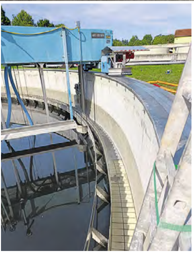
Damit die Bauwerke auch in Zukunft sicher und funktionsfähig bleiben, fallen immer wieder im Verbandsgebiet etwa Betonsanierungsarbeiten an oder es muss etwa das Ablaufgerinne (kleines Bild) erneuert werden, weil alte Fliesen nicht mehr halten.
