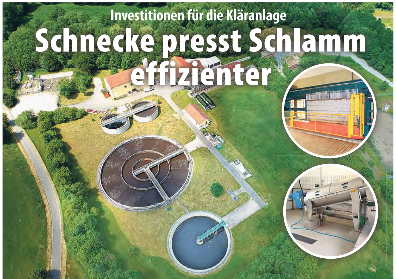
Die Schlamm entwässerung auf der Kläranlage Schleiz wird effizienter. Eine Schneckenpresse (kleines Bild unten) soll die bisherige Kammerfilterpresse ablösen.
